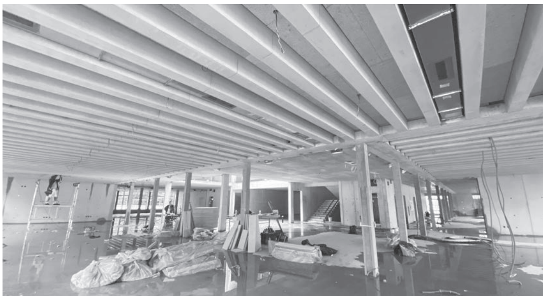
Neubau Schulhaus Burgerbeunden Ost, Einblick in die ausgeklügelte Deckenstruktur für optimale Akustik
